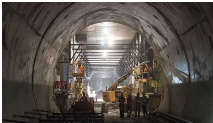
Se está construyendo un túnel y estación para una línea de metro que proporciona un sistema de transporte más seguro y sostenible en Lima, Perú.
